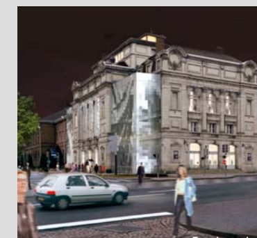
Façade sur boulevard
