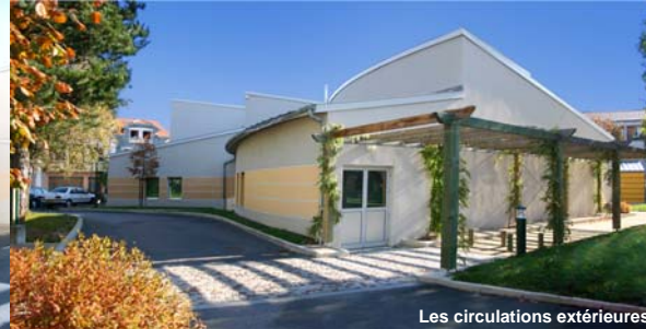
Les circulations extérieures
